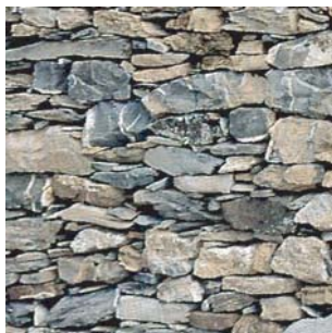
pierre de taille (mur de pierre sèche du Jura)
