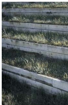
escalier, parcours GE
